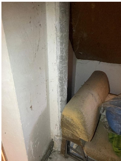
Chambre 01 Conduit fibre-ciment Détail AMIANTE
