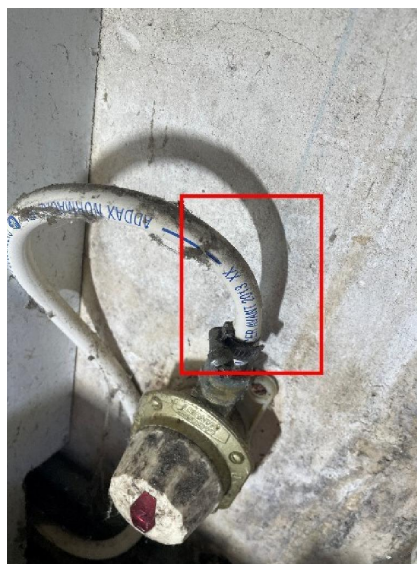
14 : La date limite d'utilisation du tuyau d'alimentation n'est pas lisible ou est dépassée. Observation : A changer avant 2013.
