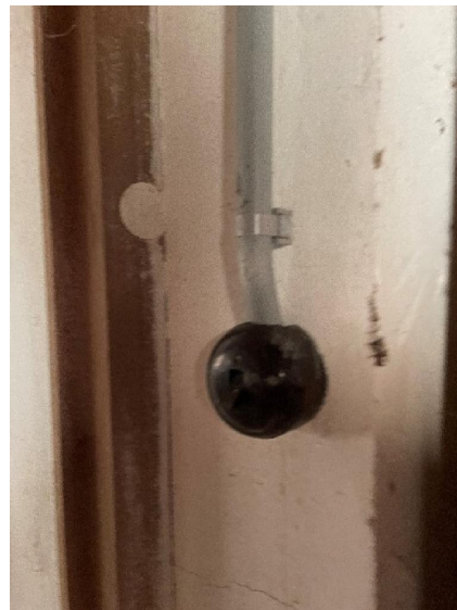
B.8.3 a) : L'installation comporte au moins un matériel électrique vétuste. Observation : Interrupteur en bakelite .... Vétuste.
