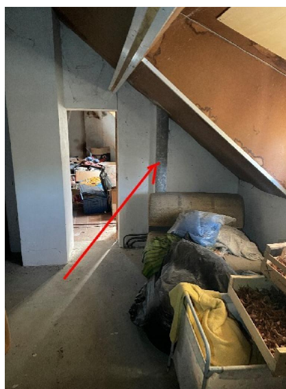
Chambre 01 Conduit fibre-ciment AMIANTE
