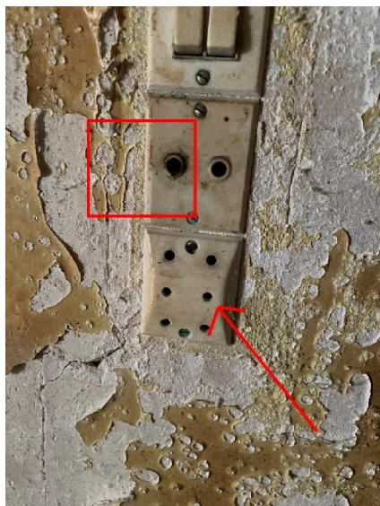
B.8.3 b) : L'installation comporte au moins un matériel électrique inadapté à l'usage. Observation : Matériel inadapté à l'usage Trace de brûlée sur prise .
