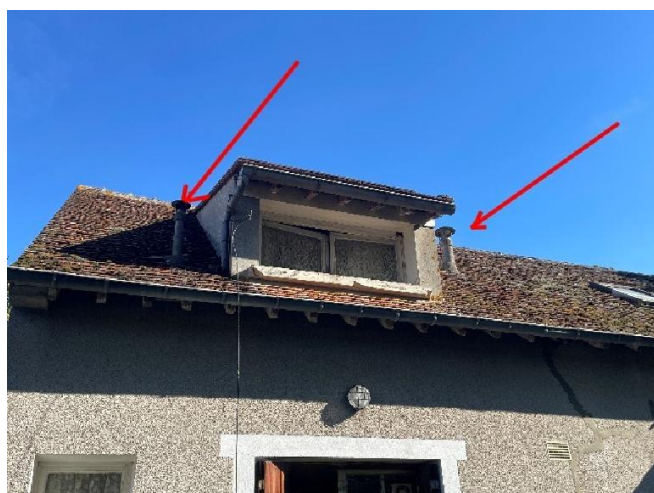
Localisation des conduits sur la toiture versant Sud.
