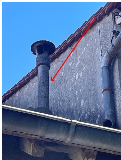
Exterieur Toiture versant Sud A gauche de la lucarne Conduit Fibre-Ciment AMIANTE
