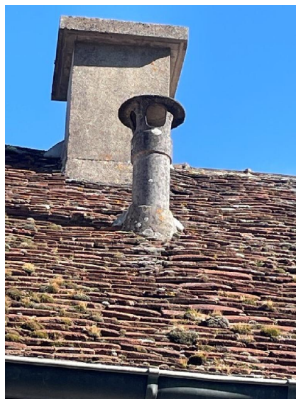
Exterieurs : Toiture versant Sud A droite de la lucarne Conduit fibre-ciment AMIANTE
