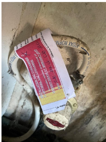
11a : Au moins un appareil est raccordé en gaz avec un tube souple. Observation : Pose d'une étiquette DGI.
