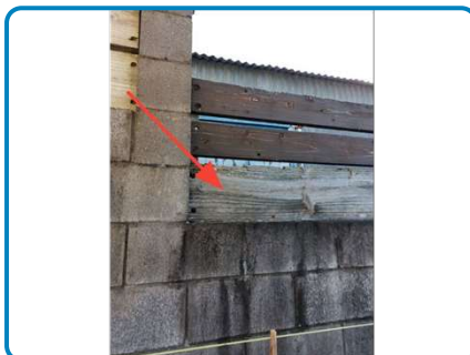
Termites de bois sec - Indices d'infestation : Altérations dans le bois, dégradations - Fèces (Vermoulures) sur Mur de clôture Crépi ciment peint + Planches bois
