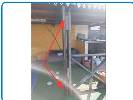
Termites souterrains - Indices d'infestation : Termites en activité - Galeries-tunnels, cordonnets, concrétions, dégradations sur Poteaux Bois
