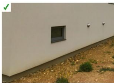
Départ de l'ITE à 15 cm minimum du sol. L'isolation des parties enterrées est assurée par du verre cellulaire. ✅
