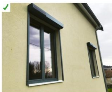
Les volets roulants sont fixés au nu extérieur de l'ITE avec des accessoires adaptés. Le pont thermique est ainsi évité. ⚠
