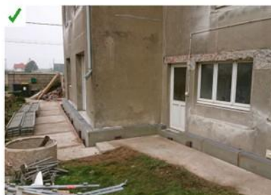
Les dalles ciment de la terrasse sont enlevées sur une largeur d'environ 40 cm, ce qui permet de décaisser le pourtour de la maison et d'isoler le soubassement.
