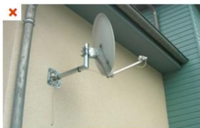
Une antenne parabolique a été installée après la réception de l'ITE. Le fil traverse l'ITE et le mur support. L'étanchéité à l'air du mur support et l'étanchéité à l'eau de l'ITE sont dégradées. ☹
