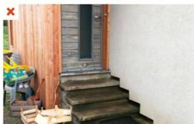
L'escalier en béton n'est pas désolidarisé de la façade isolée par l'extérieur et crée un pont thermique. ⚠
