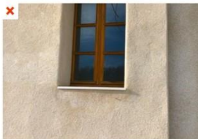
L'isolation par l'extérieur de cette maison s'arrête au niveau du mur mitoyen séparant les deux propriétés. Aucun retour d'isolant par l'ITI n'a été prévu sur ce mur. ©AOC
