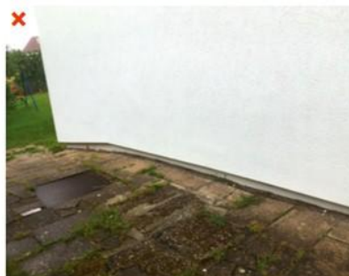
L'absence d'isolation des soubassements crée un pont thermique au niveau de la dalle basse.
