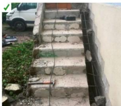
Désolidarisation de l'escalier portant avec suppression du ferrailage avant la mise en œuvre d'une ITE. Les aciers affleurants sont traités contre la corrosion. ⚠
