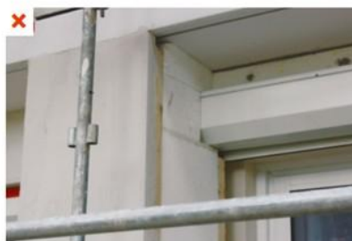
Pont thermique sur toute la longueur du coffre de volet roulant et maintenance impossible sans démontage localisé de l'ITE en appui du coffre. ⚠
