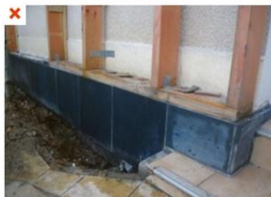
Le soubassement a été isolé avec des panneaux de liège et recouvert d'un parement de protection. Les marches en béton n'ayant pas été désolidarisées, elles créent un pont thermique. ⚠
