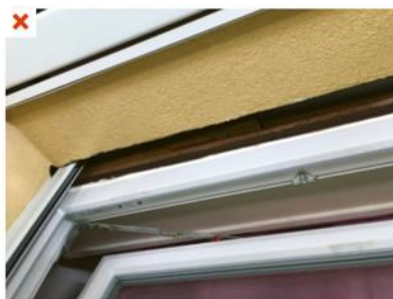
Pont thermique par le caisson de volet roulant extérieur non isolé et situé derrière l'ITE. ⚠
