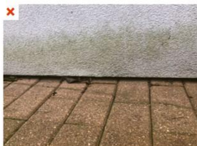
Développement de mousse et de moisissures sur une ITE en pied de façade du fait du rejaillissement de l'eau depuis les pavés. ❌
