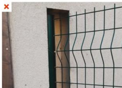
L'interruption de l'ITE au droit du poteau de fixation de la clôture engendre un pont thermique. ©AQC
