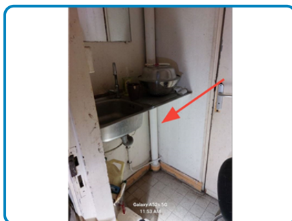
Décision opérateur n° 2 : Conduit(s) de fluide Fibres ciment (dans Lot n°11 (Inde Austral) Dégagement)
