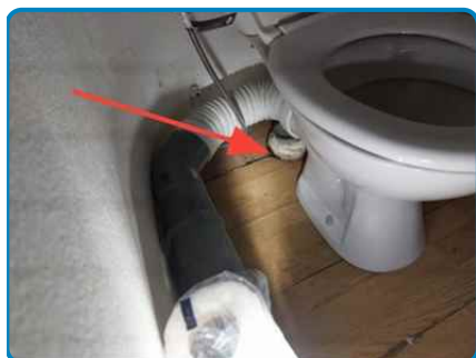
Décision opérateur n° 1 : Conduit(s) de fluide PVC + Embrase Fibre Ciment (dans Lot n°10 (Placidom) WC)
